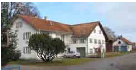
„Bachstrasse“ – markante Giebeldrehung im Laufe der Zeit – ablesbar an der Architektur.
