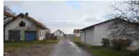
Offene Hofsituation mit prägendem Nebengebäude, rechts Fehlentwicklung aufgrund der Gebäudeproportion
